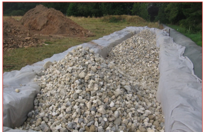
Mise en place du géotextille
