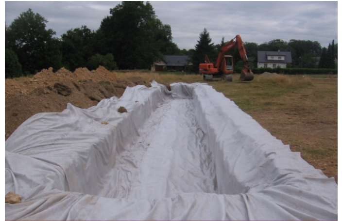
Mise en place du géotextille
