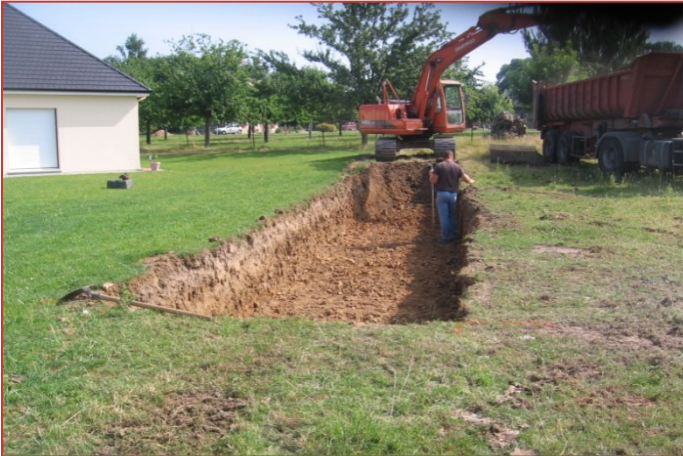
Terrassement du massif drainant
