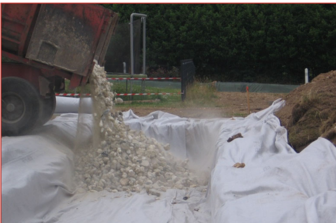
Mise en place de la grave
