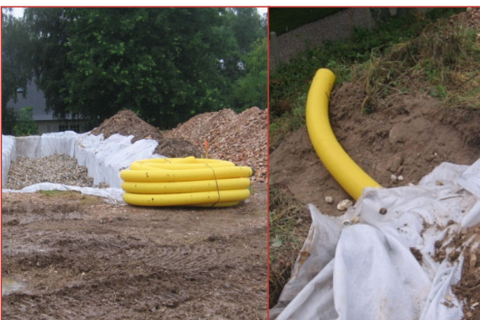
Installation de la canallisation de drainage
