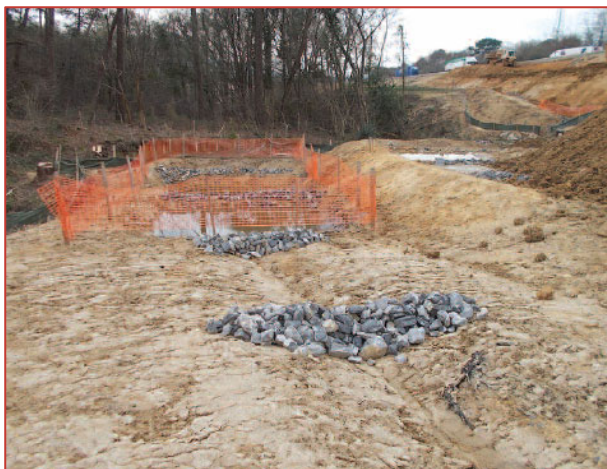
↑ Noue équipée de seuils en granulats concassés
